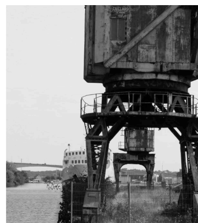
Le quai Allainguillaume en 2019. Un quai de désarmement, une friche qui sert de parking et deux grues qui rouillent tranquillement
