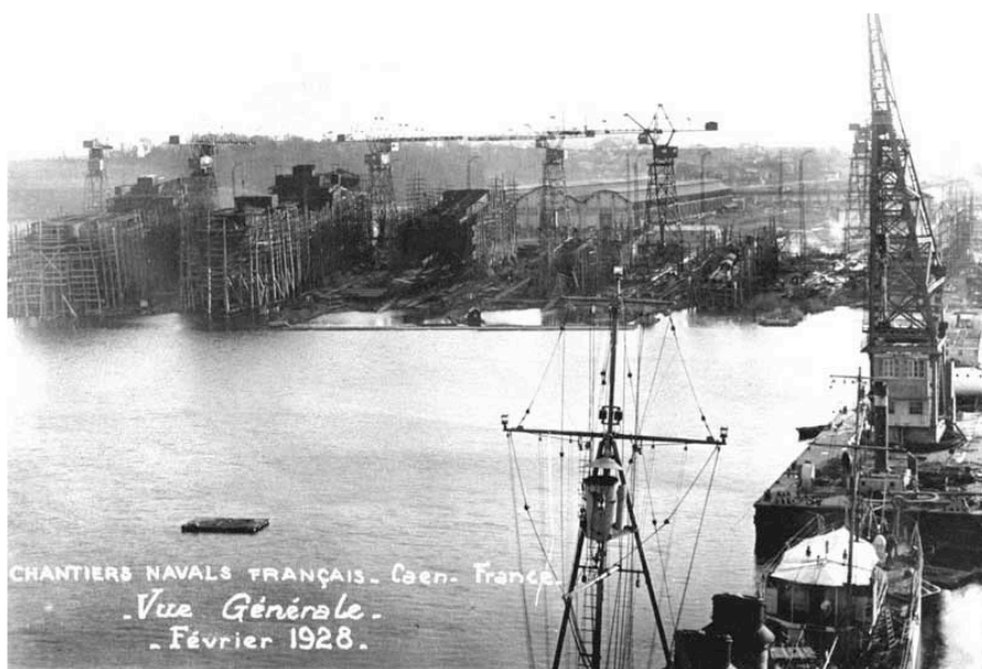
Vue générale des chantiers en 1928. On voit sur cale les deux pétroliers soviétiques, un cargo et un sous-marin. Sur le devant est en armement un contre-torpilleur polonais. À droite le ponton-grue pour charger les pièces lourdes : chaudières, moteurs, artillerie, etc ...
